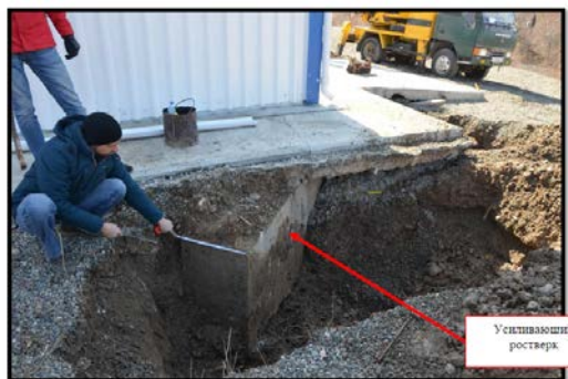
фото 2.7. Шурф № 3. Усиление фундаментов колонн представлено железобетонными ростверками. На фото усиление фундамента на пересечении осей 12 и Г.
